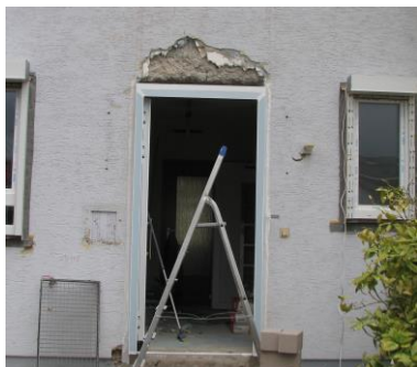
Abgebrochene Balkonplatte und abgebrochenes Vordach zur Minimierung der Wärmebrücken
