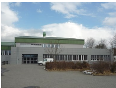
Eingangsbereich nach der Modernisierung
