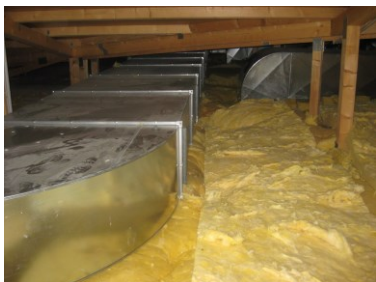
Gedämmte oberste Geschossdecke und Lüftungskanal
