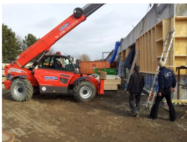
Einbau der Holzfertigteilelemente vor die ehemalige Fassade
