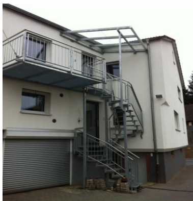
Neuer außenliegender Treppenaufgang
