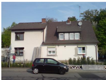
Gebäude vor der Modernisierung
