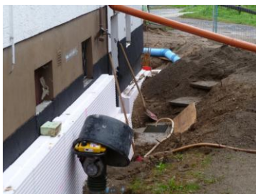
Dämmung der Kellerwände
