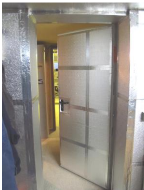
Gedämmte Kellertür
