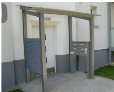
Thermisch entkoppeltes Vordach im Eingangsbereich
