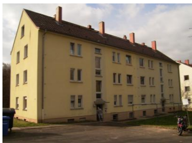
Gebäude vor der Modernisierung
