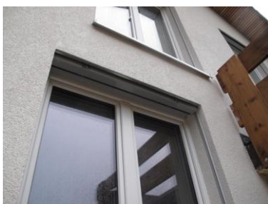
Eingefahrne Verschattungseinrichtung am Westfenster
