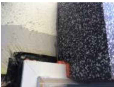
Überdämmung des Fenster-rahmens zur Verringerung der Wärmebrücken
