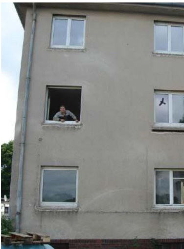
Tevesstraße vor der Sanierung
