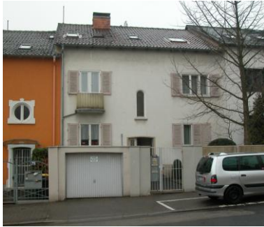
Ansicht Ostseite vor der Modernisierung
