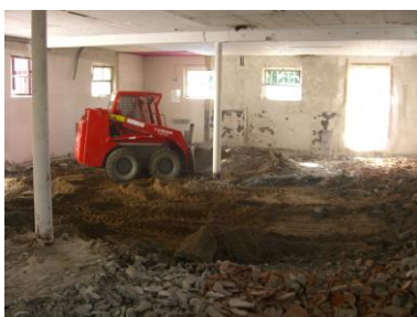
Vorbereitung für die neue wärme gedämmte Bodenplatte
