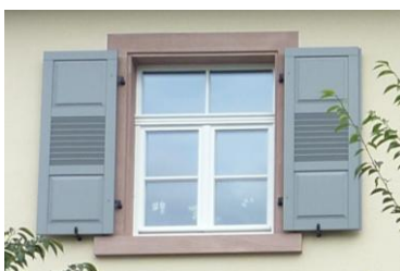
Fenster nach der Modernisierung
