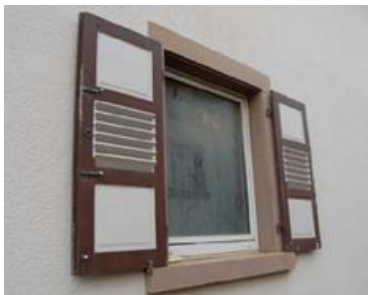
Fenster vor der Modernisierung
