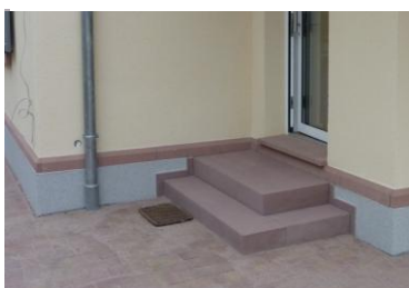
Erhalt der Gebäudeoptik durch Sandsteinelemente auf der Dämmschicht
