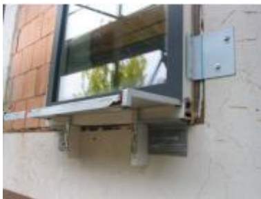
Montage der Passivhausfenster vor der Bestandswand
