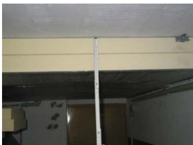
Dicke der Kellerdeckendämmung
