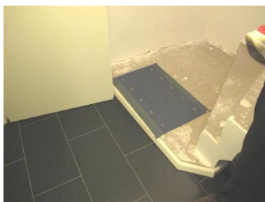
Dämmung des Kellerbodens (verminderte Stufenhöhe)
