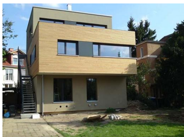
...nach der energetischen Modernisierung
