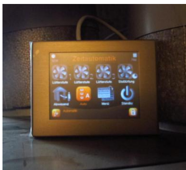
Bedienelement (Lüftungsanlage)
