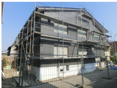
Eingerüstetes Gebäude mit vollständig angebrachter Außenwanddämmung
