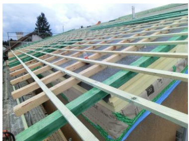
Aufsparrendämmung mit aufgesetzter Dachlattung
