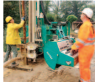
Bohrung für Erdwärmesonde
