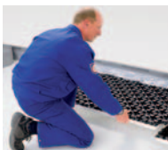
Die Installation einer Fußbodenheizung ...
