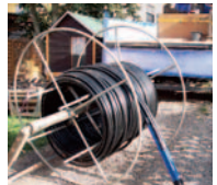
Installation der Erdsonden
