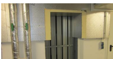
Begleitdämmung an den aufgehenden Kellerwänden zur Reduzierung der Wärmebrücken
