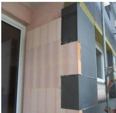
Außenwanddämmung mit ver- schiedenen Dämmstoffqualitäten
