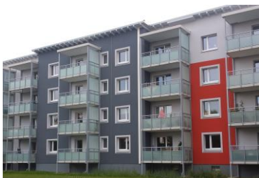
Gebäude mit modernisierten wärmebrückenfreien Vorstellbalkonen
