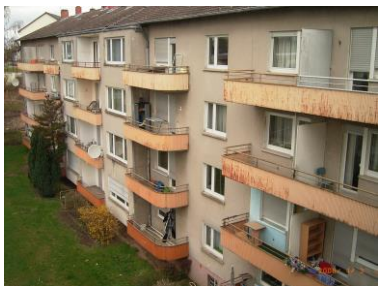
Bestandsgebäude mit ehemaligen einbindenden Balkonen
