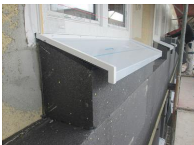
Dämmkeil unterhalb der Fensterbank
