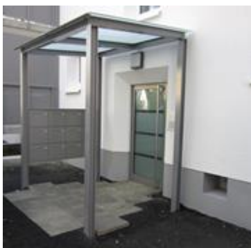
Thermisch optimierte Vordach-Konstruktion
