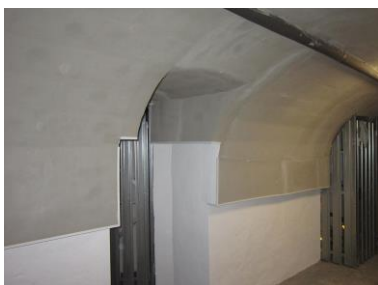
Verputzte Dämmung der gewölbten Kellerdecke
