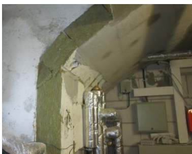
Unverputzte Mineralfaserdämmung unter der gewölbten Kellerdecke
