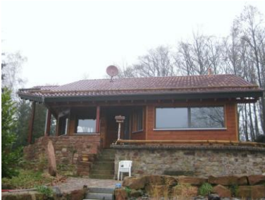
Süd-West-Ansicht nach der energetischen Modernisierung
