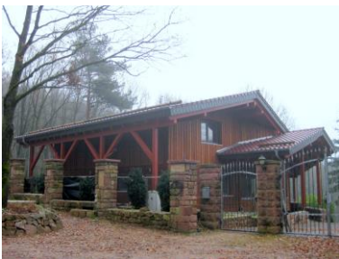
Ost-Ansicht nach der energetischen Modernisierung
