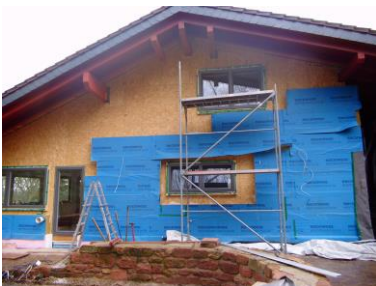
Aufgesetzte Mineralfaserdämmung (mit blauer Folie kaschiert) auf der Außenschalung der Holzständerwand
