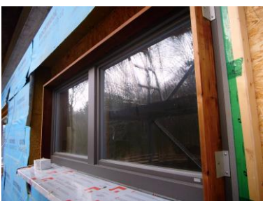
Fenster mit 3-seitigen Montagehölzern für den Einbau in die Holzständerwand
