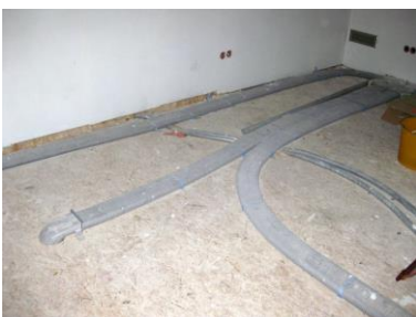
Lüftungsverteilung durch Flachkanäle vor Aufbau des Fußbodens
