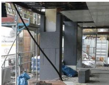
Gedämmte Stützen im Außenbereich
