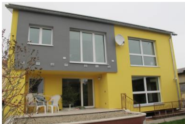
...und nach der energetischen Modernisierung
