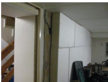
Innenwanddämmung des thermischen Abschlusses zum Treppenhaus des Kellergeschos
