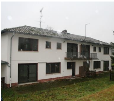
Gebäude (Lorbacher Straße 64-66) vor der Modernisierung
