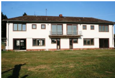
Gebäude (Lorbacher Straße 60-62) vor der Modernisierung
