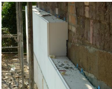
Dämmung der Außenwand
