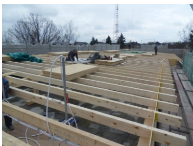
Hohlraum zwischen oberster Geschossdecke und Sparren (vor Einblasen Zellulosefaserdämmung)
