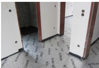
Wärmedämmung der Bodenplatte
