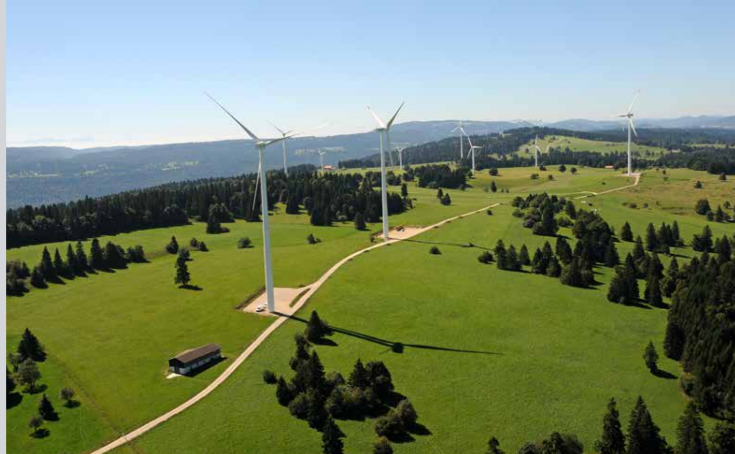
Der zurzeit grösste Windpark der Schweiz auf dem Mont Cresin BE.
